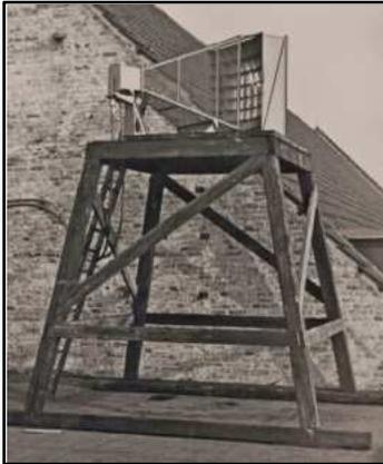
Hornantennen für vertikale und horizontale Polarisation, hier aber zusätzlich mit einer vor das Horn gesetzten „Linse“, einem Gitter aus speziell geformten
