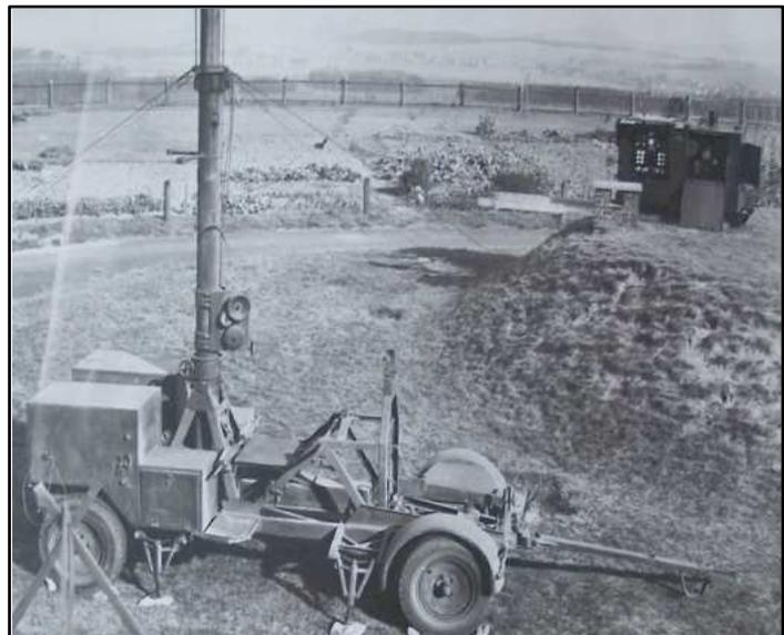
die Antennen. Ein Original-Antennenanhänger Sd.Kfz.127 des „Stuttgart“ und ein stationärer 30m-Teleskopmast wurden aufgebaut. Beide mit je einer Linsenantenne. Im Hintergrund rechts das Dieselaggregat für die Stromversorgung. Der in Sichtweite des Sachsenwerkes in Radeberg gelegene Steinberg ist bis 1990 eine Gegenstelle für die Erprobung von Richtfunkgeräten geblieben.
