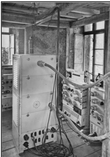
Das sechste Funkfeld über 36 km führt zur **Endstelle Dresden** in Hellerau (Bilder unten). Der Stationsraum ist geräumig. Da stehen zwei RVG 902A, eines für das nur anfangs bei der Startmessung benutzte Funkfeld 7 zum Collm, das andere für den Valtenberg und mehrere kleine TF-Geräte ME 8.
