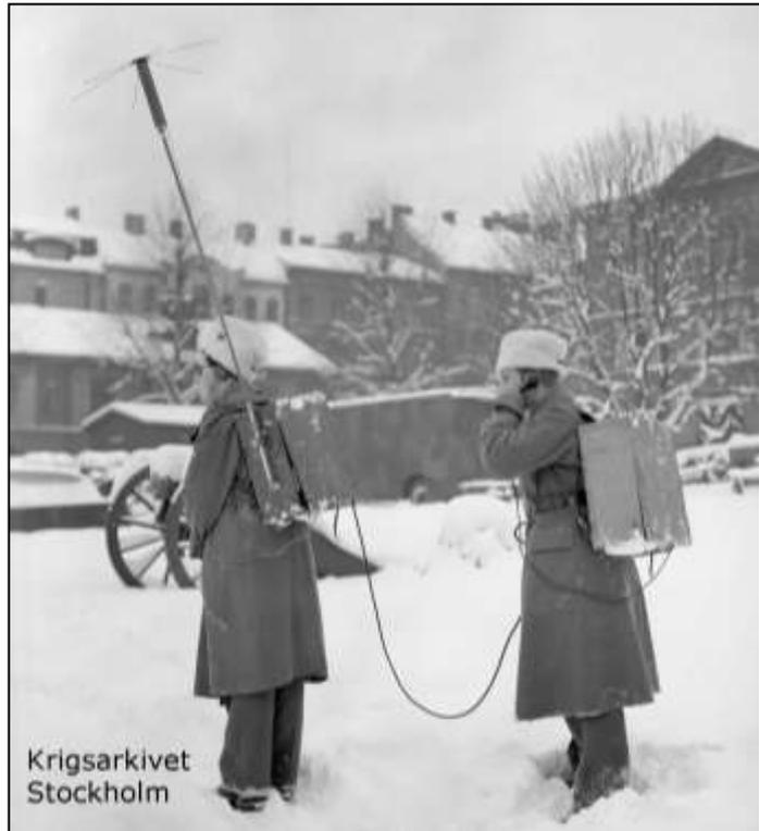
21 Geräte SE 499 A sind während des Finnisch-Sowjetischen Winterkrieges 1939/40 zur Unterstützung der finnischen Armee an Finnland geliefert worden. Diese Geräte wurden bei der finnischen Armee zuerst als „Telefunken C“ und „Telefunken CD“, schließlich aber unter der Bezeichnung **VRFSA** eingesetzt.<sup>5</sup> Diese Bilder aus dem Fotoarchiv der Finnischen Verteidigungs-
