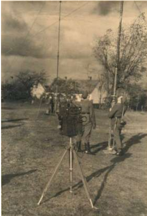
Elster Mast STM 2 mit Antenne neben schwerem RV-Trupp FuG 03 "Stuttgart"
