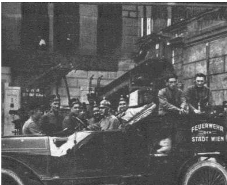
Fahrbare Sende- und Empfangsstation der Wiener Feuerwehr
