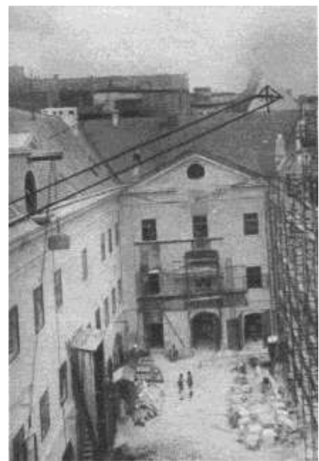
Hochantenne der Wiener Feuerwehr „Am Hof“
