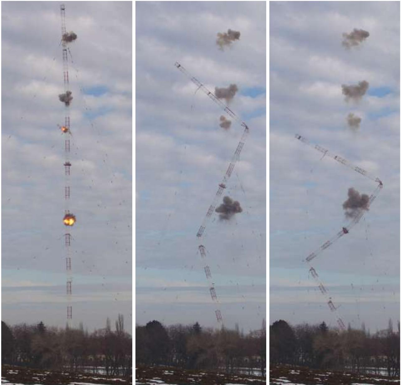
Die erste Sprengladung durchtrennte wieder die drei Abspannungen einer Seite. Damit wollte man erreichen, dass keine Baulichkeiten zu Schaden kommen, falls sich der zusammenstürzende Mast nicht an den vorgegebenen Plan halten sollte. Nach 100 ms wurden weitere vier in unterschiedlichen Höhen angebrachte Ladungen gezündet. Der angezählte 80 Tonnen Riese sackte wie eine Ziehharmonika zusammen und fiel auf die vorberechnete Seite. Der Explosionsknall war angeblich in ganz Wien zu hören.
