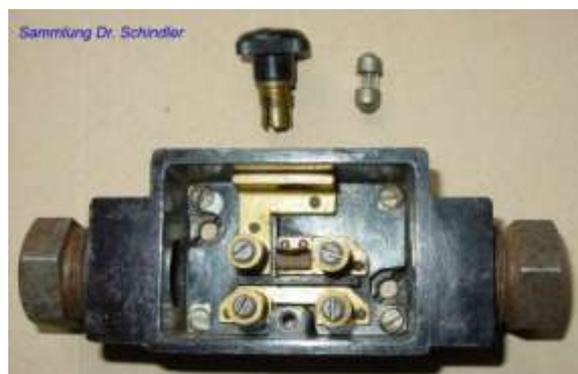
ab Panzer III, Ausf.D), also etwa ab Baujahr 1938, wurden alle Umformer einer Panzerfunkanlage zentral mit 40 A bzw. 80 A abgesichert.
