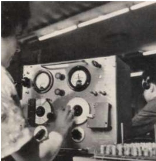
Die einzelnen Baugruppen werden auf Prüfmaschinen sorgfältig geprüft und einjustiert, bevor sie ins Gerät eingesetzt werden.
