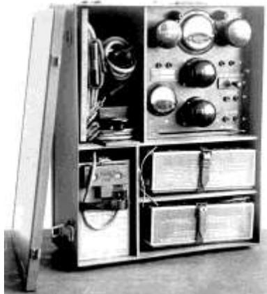
getrenntem Sender **Tf. A** (links) und Empfänger **Tf. 1** (rechts) mit jeweils eigenen Batterien. Alle „Funksprechgeräte“ bis 1932 benutzten **niedrige Dipolantennen**, die in 80 bis 100cm Höhe über dem Erdboden ausgespannt waren.
